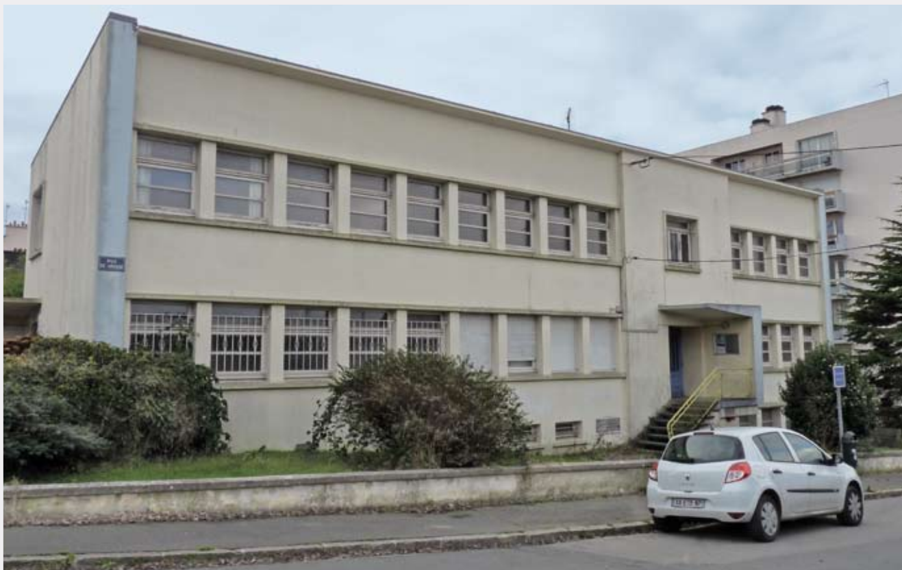
Le bâtiment à rénover, boulevard Montaigne, Brest.
